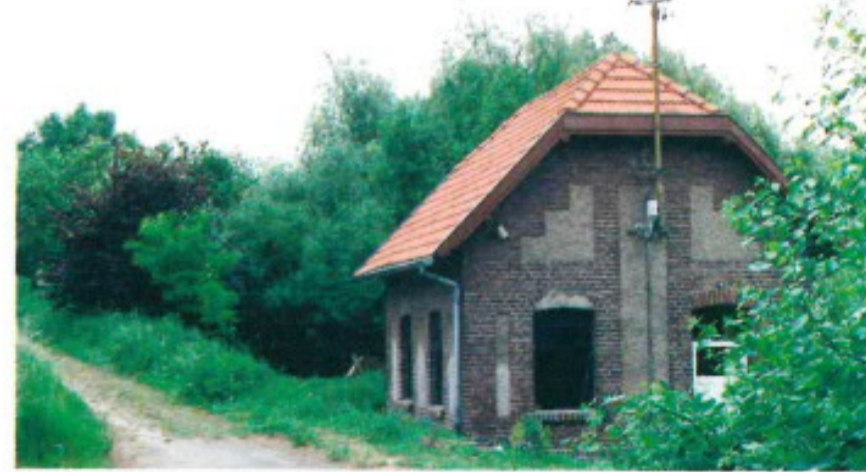
Rückbroich mit Pumpenhaus, Brenig, Tour Rot, Nr. 6
